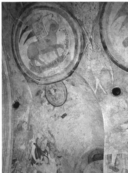
9: Deux vases du temple de Villette, disposés autour d'une fenêtre. — In der Kirche von Villette sind Schalltöpfe auch um die Kirchenfenster eingebaut worden.
