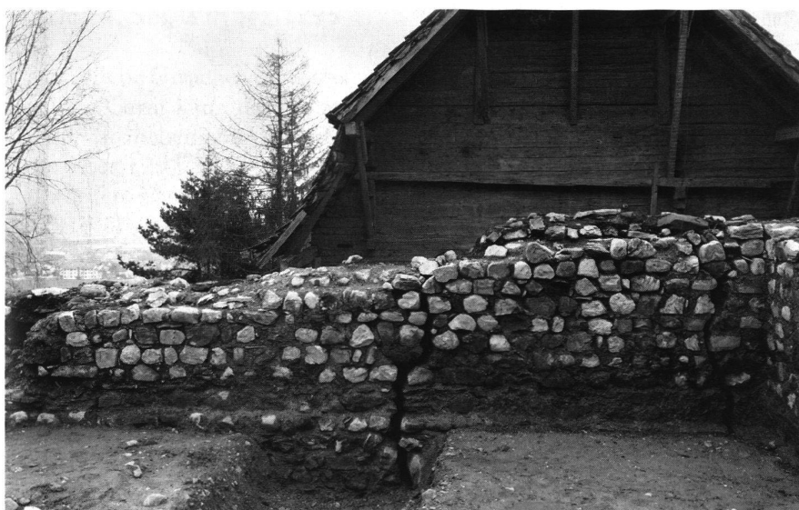
8: Auswirkungen eines Erdbebens, möglicherweise durch ein Erdbeben ausgelöst: Die im Bereich der Türschwelle auseinander gerutschte und abgesackte Ostmauer (oben, Bildmitte). 7 bis 30 cm breite Vertikalrisse durchziehen die gesamte Dicke der Ostmauer (unten).
