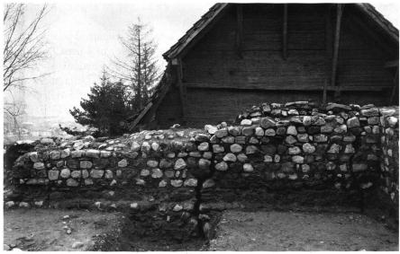
8: Auswirkungen eines Erdrutsches, möglicherweise durch ein Erdbeben ausgelöst: Die im Bereich der Türschwelle auseinander gerutschte und abgesackte Ostmauer (oben, Bildmitte). 7 bis 30 cm breite Vertikalrisse durchziehen die gesamte Dicke der Ostmauer (unten).
