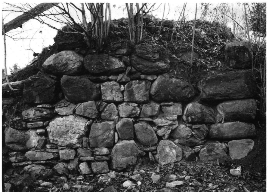
2: Aussenschale der Nordmauer und Nordwestecke des Wobnturmes (Aufnahme 1999). Die Eckquaderung enthält bis 70 × 50 cm grosse Steinblöcke.
