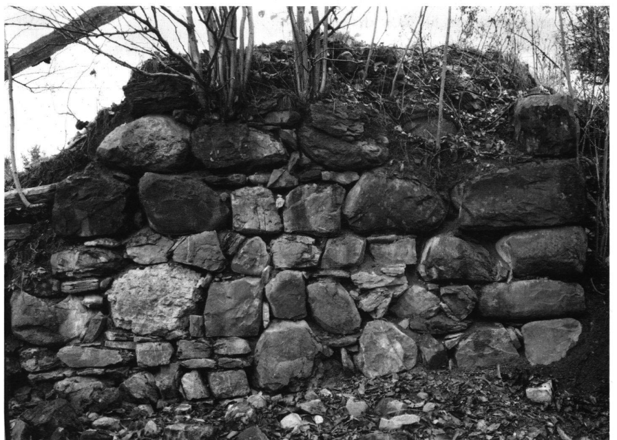
2: Aussenschale der Nordmauer und Nordwestecke des Wohnturmes (Aufnahme 1999). Die Eckquaderung enthält bis 70 × 50 cm grosse Steinblöcke.
