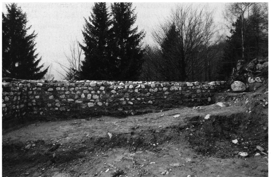
7: Innenschale der Südmauer. Im Gegensatz zu den trutzigen Aussenschalen (vgl. Abb. 2) bestehen die Innenschalen aus kleinteiligem Steinmaterial.
