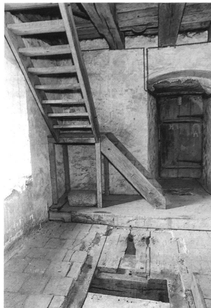
8: Spittelturm, 2. OG mit Loch zum Gefängnis und Seilrolle an der Decke (von Süden, Podest und Treppenverlauf nicht ursprünglich).
