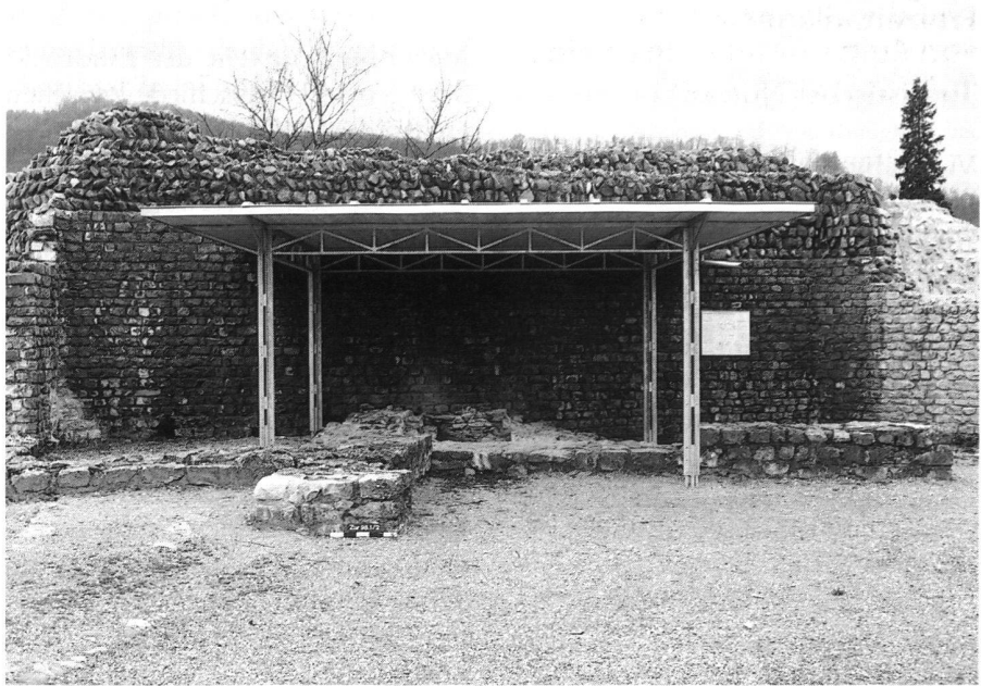
12: Spätromisches Kastell Zurzach (1997). Schutzdach über dem frühchristlichen Taufbecken.
