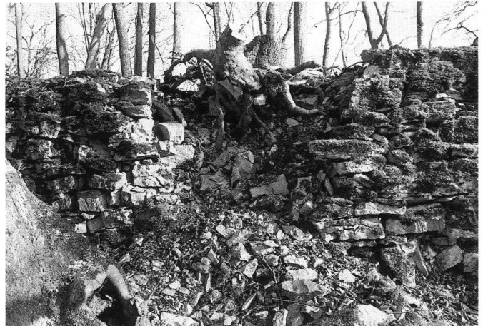
3: Densbüren, Ruine Urgiz (1996). In der Trockenmauer des Burggrabens sind an mehreren Stellen über die Jahre grosse Schäden entstanden.
