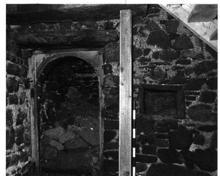
8: Haus Nr. 5/6: Kellertrennwand von um 1265 mit Rundbogentür, Wandnische und darüber einem eingemauerten Kochtopf; links die Stadtmauer.
