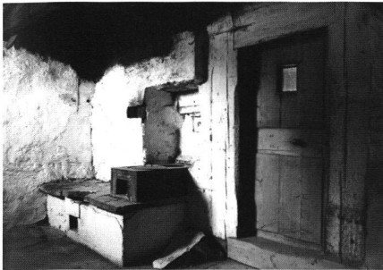
18: Haus Nr. 16: Turmküche in der Turmerneuerung von 1610 mit Herdstelle, wohl des 18. Jhs. und offenem Rauchfang.
