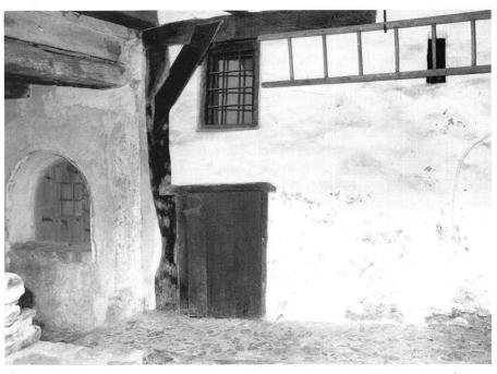
5: Gassenseitiges Fassadendetail des Erdgeschosses von Haus Nr. 7: Reste einer Boblenständer-Konstruktion der Zeit vor/um 1370 mit späterer Ausmauerung, rechts der einstige Rundbogeneingang im Putz eingeritzt und darüber eine frühe Luzide. Das Laubengebälk ist mit 1370 dendrodatiert.
