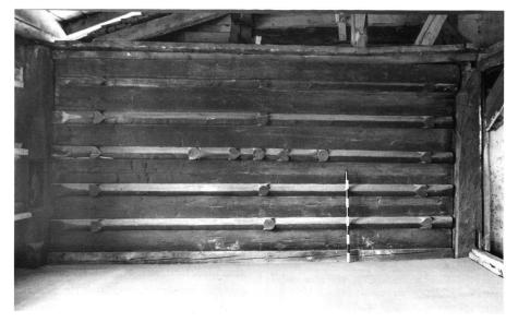
11: Haus Nr. 8: Bohlenbalkendecke aus der Stube, später im 2. Obergeschoss als Wandausfachung zweitverwendet. Diese Decke von 1409 d zählt weitherum zu den frühesten dieser Art.
