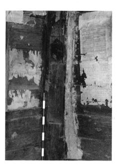
12: Haus Nr. 8, Boblenständerbau von 1409 d: südlicher Eckständer der Stube mit Zierschräge und Nische (als «Herrgottswinkel» ?) – Wände mit handgeschriebenen Akten der Zeit von 1798 bis 1804 beklebt.
