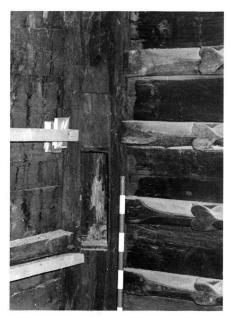
13: Haus Nr. 8, Bohlenständerbau von 1409 d: südlicher Eckständer der grossen Kammer, ziergeschrägt und mit Nische versehen; rechts die zur Wandausfachung zweitverwendete Stubendecke von 1409 d
