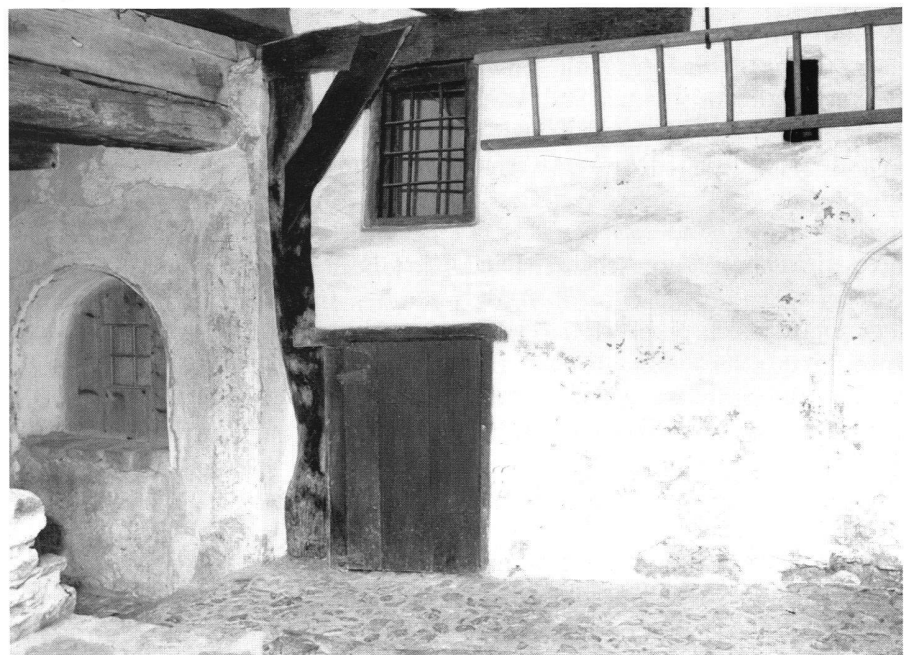
5: Gassenseitiges Fassadendetail des Erdgeschosses von Haus Nr. 7: Reste einer Bohlenständer-Konstruktion der Zeit vor/um 1370 mit späterer Ausmauerung, rechts der einstige Rundbogeneingang im Putz eingeritzt und darüber eine frühe Luzide. Das Laubengebälk ist mit 1370 dendrodatiert.
