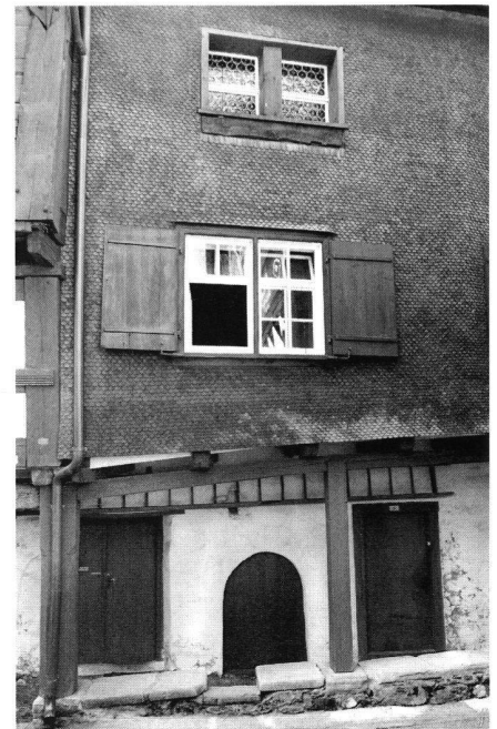
4: Die gassenseitige Fassade der Häuser Nr. 7 links und Nr. 8 rechts zeigt eine architektonisch klar erkennbare Hofstättengrenze. Doch der Angensehein trägt: die drei Türen im Erdgeschoss bedeuten von links nach rechts: Haustür zu Nr. 7, gemeinsamer rundbogiger Kellerzugang zu Nr. 7 und 8, Haustür zu Nr. 8; die Kammer im 1. Obergeschoss gebürt zu Nr. 8, jene im 2. Obergeschoss (mit den Butzenfenstern) zu Nr. 7; der Eckständer links zeigt oben eine Blattsasse zu einem nach rechts weisenden Kopfband, das heisst, der Fassadenteil von Nr. 8 war ursprünglich einbeitlich mit Nr. 7 abgebunden und krachte ebenso vor, die heutige Flucht stellt eine spätere Rückversetzung dar.
