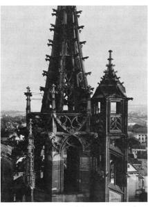
36: Basel – Münster. Fünfeckiges Treppentürmchen am Martinsturm, dessen Grundriss mit der Zehnknotenschnur abgesteckt wurde.
