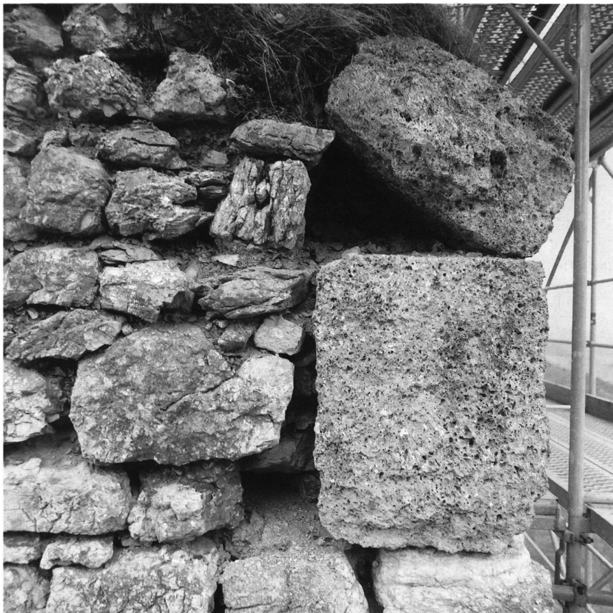
9: Arête des murs M1/M7. Les deux derniers blocs à bossage en tuf conservés au sommet de la chaîne d'angle; vue de l'W.
