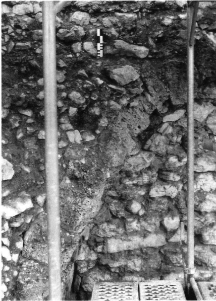
6: Ebauche sud de la voûte en blocs de tuf et face intérieure rougie au feu du mur M1 avec des restes du mortier d'origine; vue de l'E.
