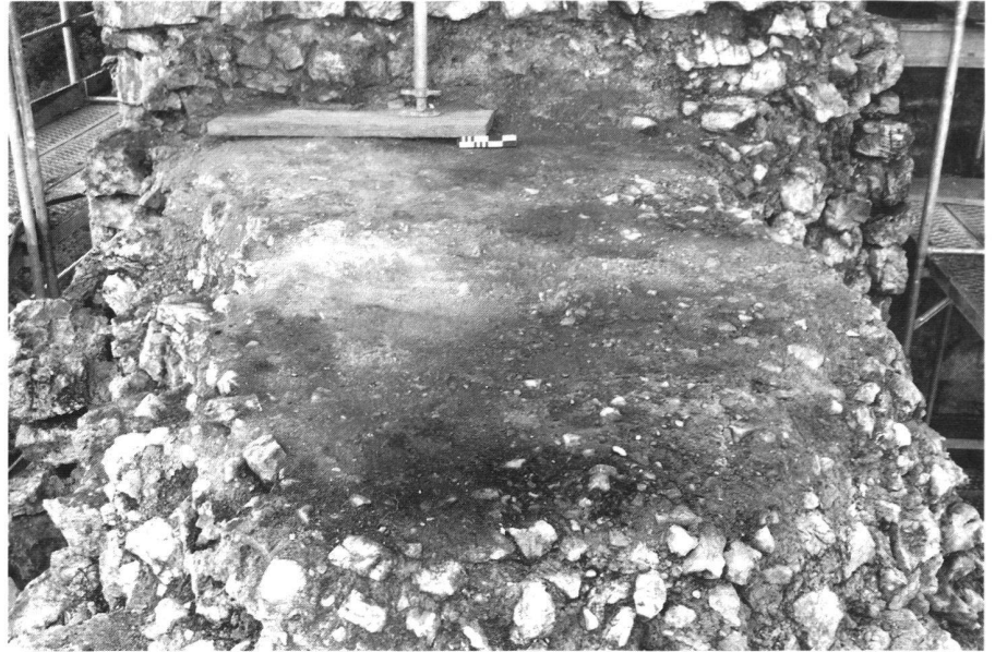
7: Mur M6. Couronne du mur rougie au feu juste devant le décrochement du mur M7; vue de l'E.
