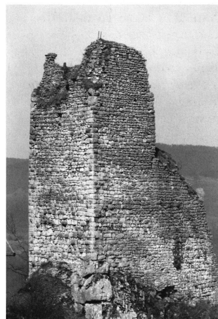
8: Etat des murs du cœur du château fort avant la restauration de 1998; vue du SW. Comparativement à la fig. 1 on remarque les pertes de substance des murailles des 140 dernières années.
