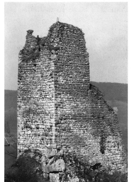
8: Etat des murs du cœur du château fort avant la restauration de 1998; vue du SW. Comparativement à la fig. 1 on remarque les pertes de substance des murailles des 140 dernières années.
