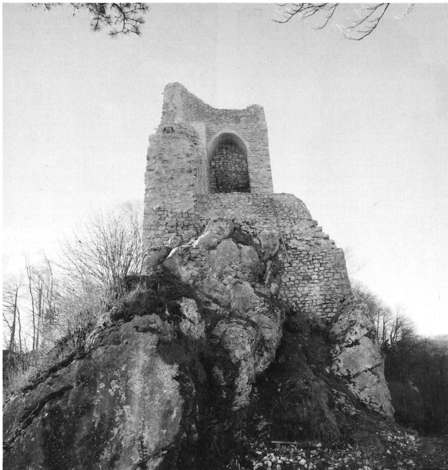
19: Château fort après la restauration complète de 1998; vue de l'E. A l'exception de la surface intérieure du mur M1 protégée par la voûte laissée dans son état d'origine, toutes les surfaces visibles des murs ont été restaurées.
