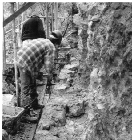
18: Mur M4. Deux maçons lors de la reconstruction de la façade effondrée pendant les travaux de consolidation; vue de l'W.
