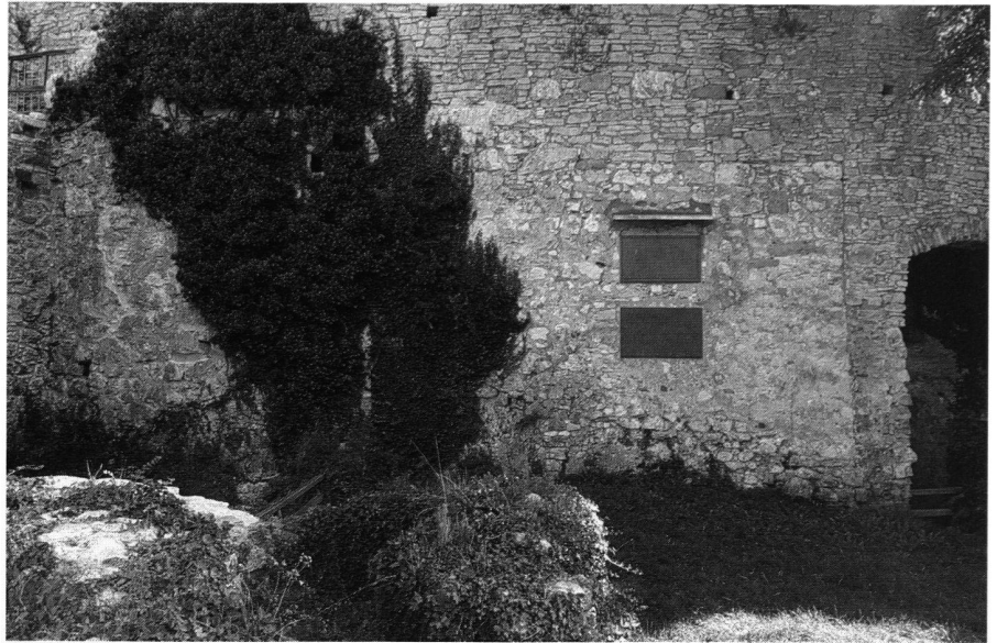
6: Innenseite (M1) des Grossen Bollwerkes von Südwesten im Zustand 1999. Links des Bewuchses ist das grossblockige Mauerwerk (M1a), rechts davon das kleinteilige Mauerwerk (M1b) zu erkennen. Man beachte die horizontal verlaufende Krone und die südöstliche Ecke des kleinteiligen Mauerwerks.
