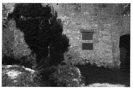
6: Innenseite (M1) des Grossen Bollwerkes von Südwesten im Zustand 1999. Links des Bewuchses ist das grossblockige Mauerwerk (M1a), rechts davon das kleinsteinige Mauerwerk (M1b) zu erkennen. Man beachte die horizontal verlaufende Krone und die südöstliche Ecke des kleinsteinigen Mauerwerks.
