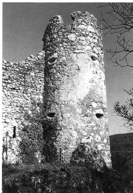
19: Südliche Schale des Doppelturmes (T3) von Süden im Zustand von 1989.
