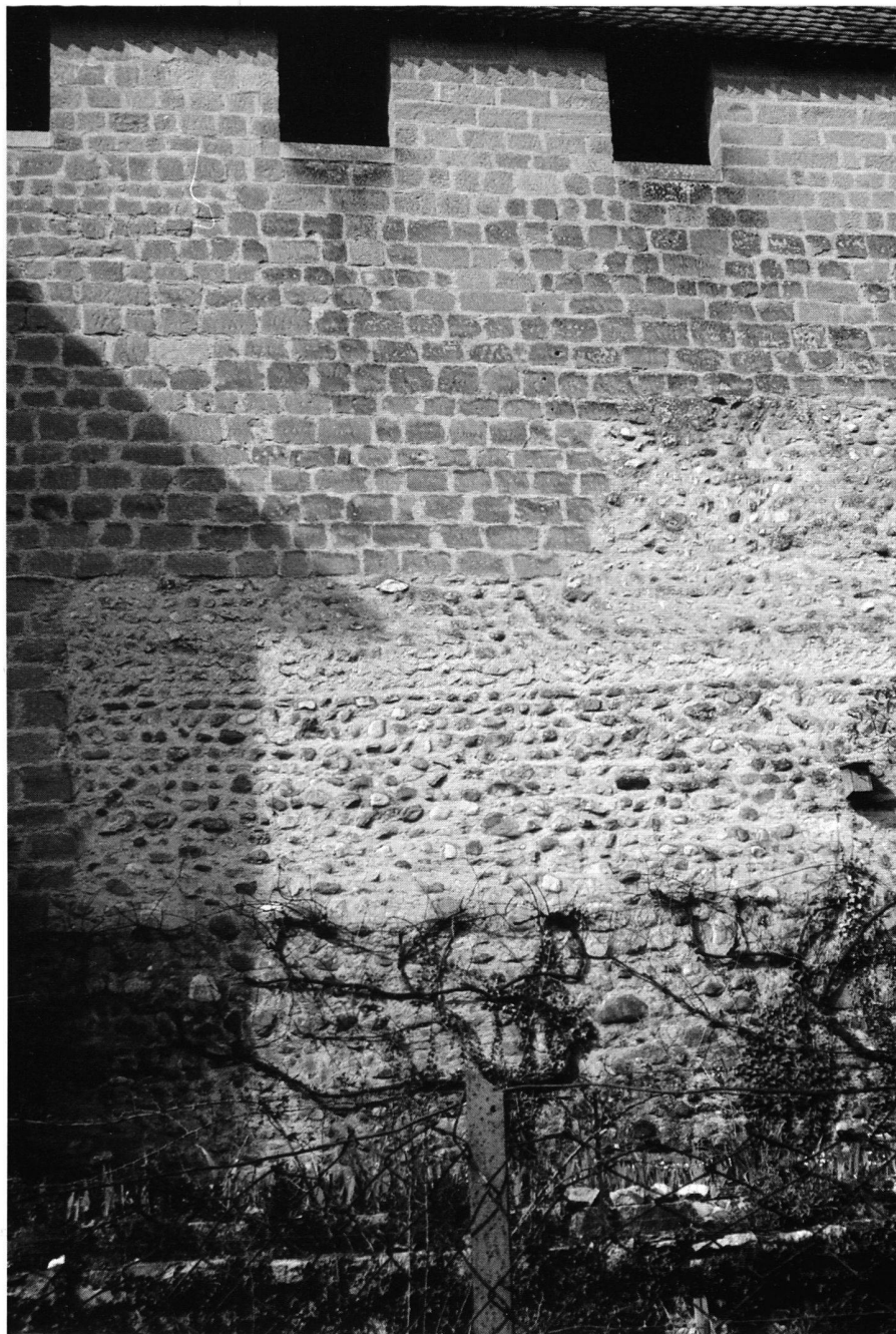
4: Ringmauer Sektor VIII: Das regelmässige Mauerwerk aus Feldsteinen stammt aus der Zeit der ersten, 1238 in Auftrag gegebenen Stadtmauer. Darüber folgen zwei Aufstockungen des 13./14. Jhs. aus verschiedenen Materialien (Feld- und Bruchstein, Kleinquaderwerk aus gelbem Neuenburgerstein von römischen Bauten usw.). Zuletzt – und links neben dem Schimmelturm ab Boden – folgt Kleinquaderwerk aus Sandstein, welches auf der Innenseite grossflächig Brandspuren von 1416 zeigt und deshalb ebenfalls noch aus dem 14. Jb. stammen muss.
