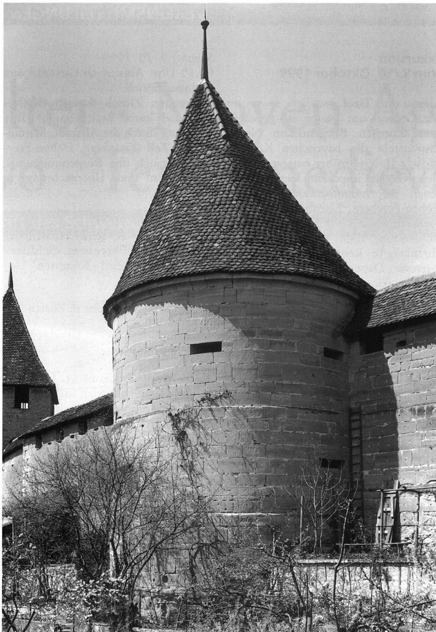
5: Der von Meister Peter 1523 gebaute Schaalturm (Nr. 11) ist ein für die Zeit typischer kleiner, gedrungener Artillerieturm. Er wurde, zusammen mit den benachbarten Mauersektoren X und XI, aus grossen Sandsteinquadern errichtet (Foto Yves Eigenmann 1993).
