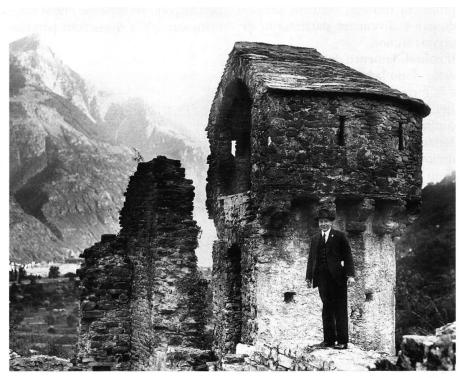
7: Sulla parte superiore della torre semicircolare poggia un parapetto sorretto da beccatelli (mensole), coperto da un tetto in piode a corsi regolari. – Die Wehrplattform des Halbrundturmes ruht auf Kragsteinen und ist mit einem Steinplattendach gedeckt (Photo Jean Gabarell, Thalwil).
