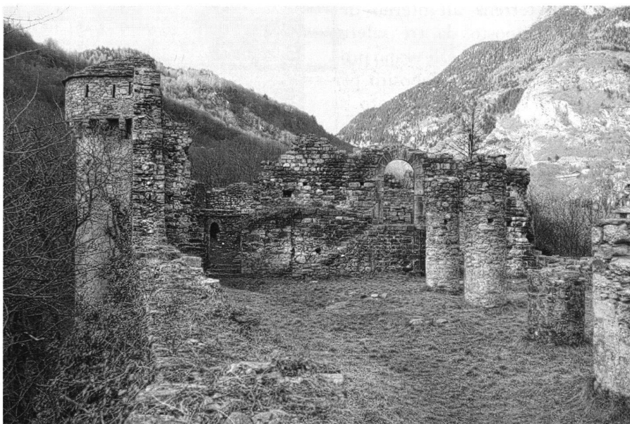
5: Veduta della rocca principale, a sinistra la torre semicircolare, a destra i pilastri mozzi di una sala terrena. – Ansicht der Hauptburg (12./13. Jh.), links der Halbrundturm (14. Jh.), rechts die Säulenreste einer gedeckten Halle.
