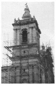
18: Vittoriosa (Birgu), Malta. Mit Stahlrohren eingerüsteter Kirchturm. Wie im Mittelalter üblich, sind nur die zur Ausführung der laufenden Arbeiten benötigten Gerüstläufe mit Brettern belegt.
