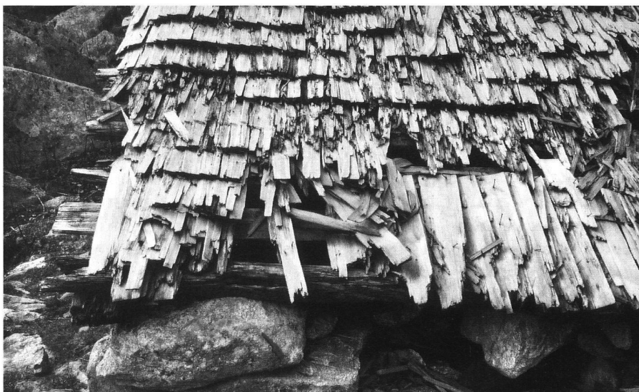
22: Meien UR. Genageltes Schindeldach einer Alphütte am Sustenpass.
