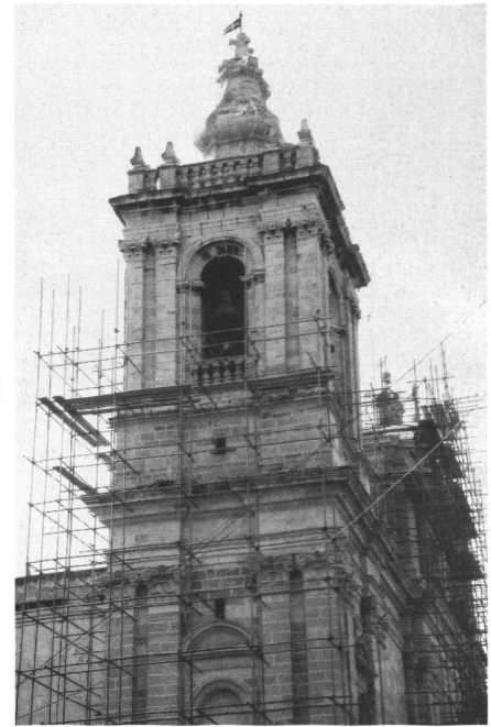
18: Vittoriosa (Birgu), Malta. Mit Stahlbrenn eingestützter Kirchturm. Wie im Mittelalter üblich, sind nur die zur Ausführung der laufenden Arbeiten benötigten Gerüstläufe mit Brettern belegt.
