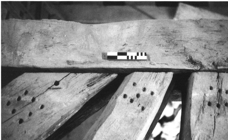
21: Sarnen OW, Archivturm (Hexenturm). Gebohrte Einschnittzeichen in den Kragbalken der Basis des ehemaligen hölzernen Obergadens.
