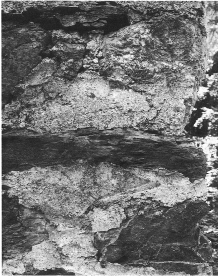
20: Malans GR, Ruine Klingenborn. Glatgestrichener Verputz im Bereich des Eckverbandes des Turmes. Unterhalb der Bildmitte ist der Abdruck einer Spitzkelle zu erkennen.
