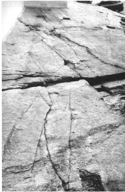
16: Flond GR, Kirche. In den anstehenden Fels gebauene Löcher zur sicheren Verankerung der senkrechten Stangen des Aussengerüsts.
