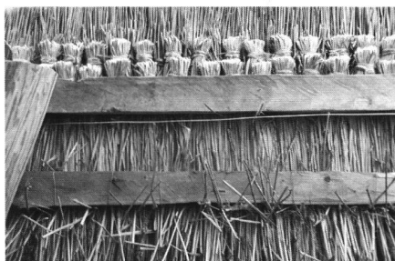
23: Brienzwiler BE, Freilichtmuseum Ballenberg. Mit Draht angebundene Schauben eines Strohdaches. Untersicht.
