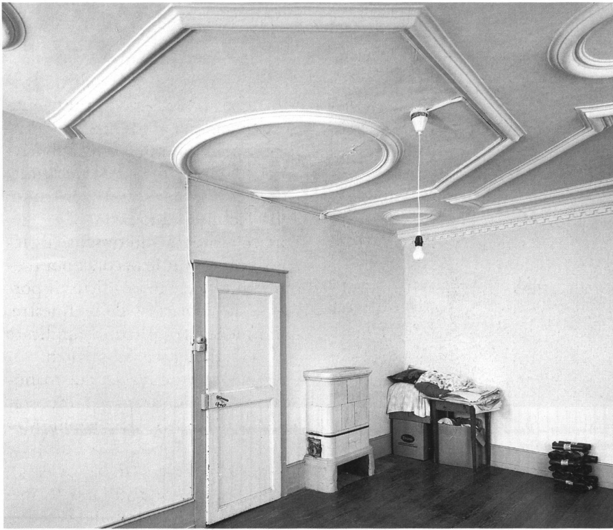
16: Yverdon – Rue du Collège 10. La grande chambre à l'arrière du premier étage, avec son plafond en stuc et la cloison à cheval sur un poêle du début du XIX e siècle.
