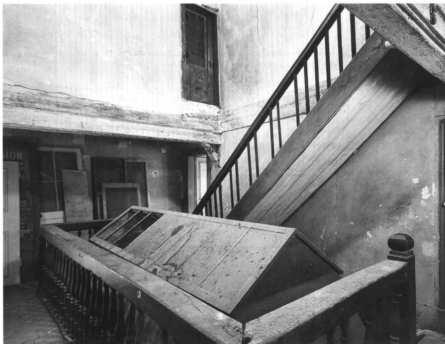
17: Yverdon – Rue du Collège 10. Le puits de jour éclairant le premier étage, avec son garde-corps à balustres en fuseaux.
