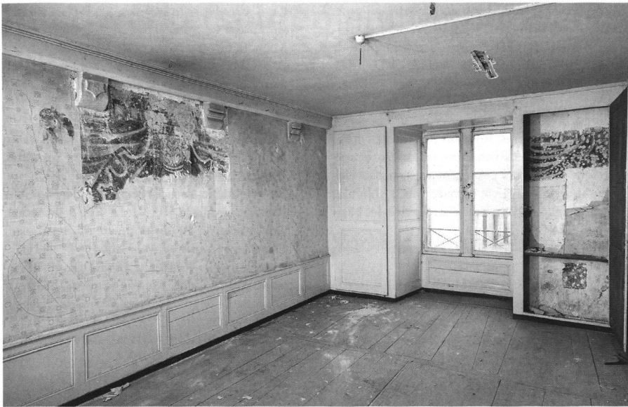
18: Yverdon – Rue du Collège 10. La chambre nord sur rue du second étage, avec son décor peint de colonnes à chapiteau soutenant des draperies.
