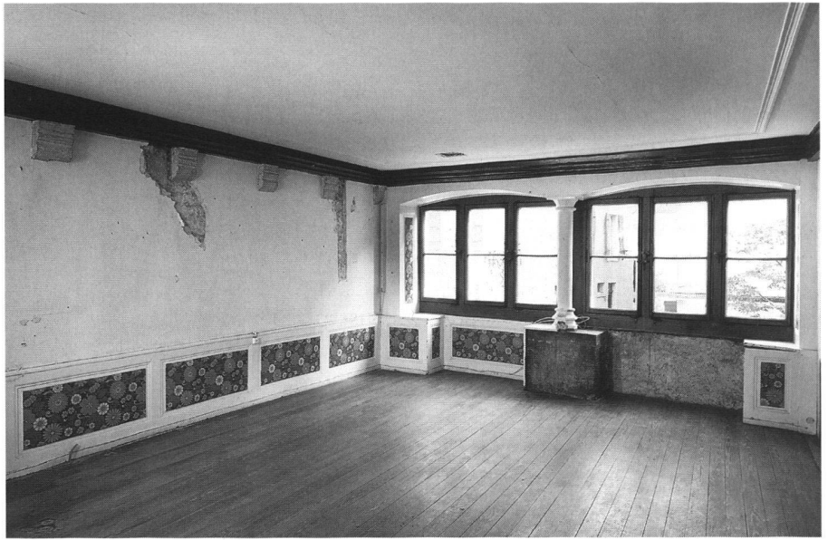
13: Yverdon – Rue du Collège 10. Vue de la grande chambre sur rue du premier étage avec ses deux triplets de fenêtres à coussiège.
