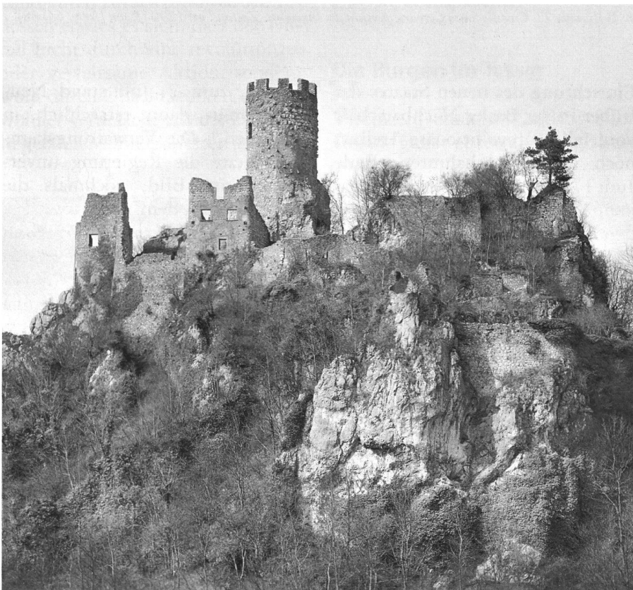
10: Neu-Falkenstein, Balsthal SO, Zustand um 1930 (J. Gaberell, Schweizerischer Burgenverein).
