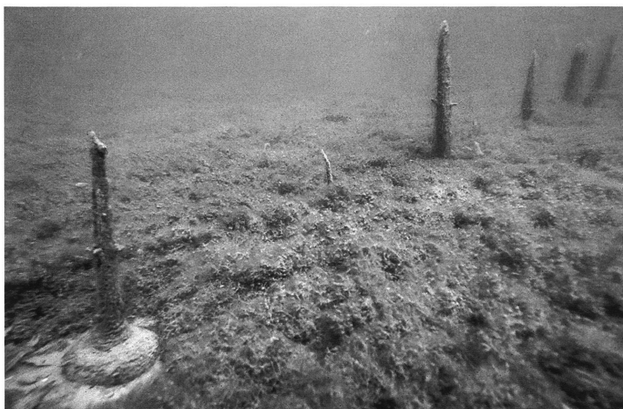
6: Von den Tauchern mit einem Wasserstrahl freigespülter, zum Absägen vorbereiteter Pfahlstumpf. «Fischzucht», äussere Pfahlreihe.
