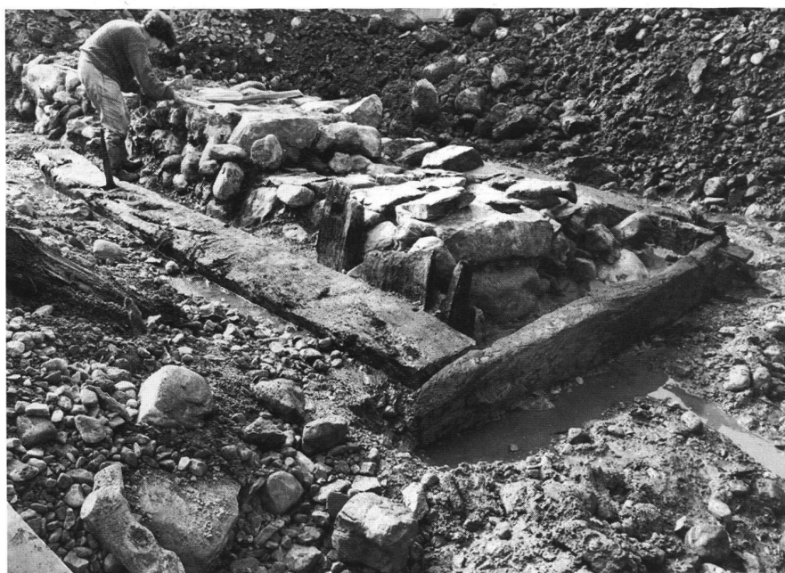
9: Le premier état du musoir sud avec son cadre de poutres.
