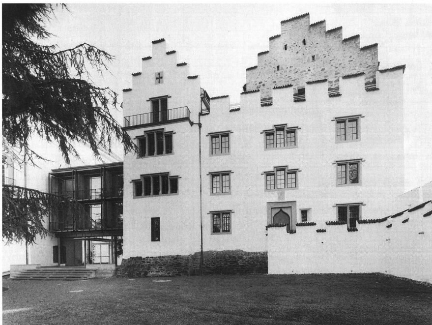
5: Nordwestansicht mit u.l.n.r.: Mitteltrakt von 1994/96 und der um 1850 in neugotischer Art umgestaltete Westtrakt; deutlich erkennbar ist die dunkle Fundamentuntermauerung von 1850 als Zeichen beträchtlicher Terrainabsenkungen (vgl. dazu auch Abb. 8).
