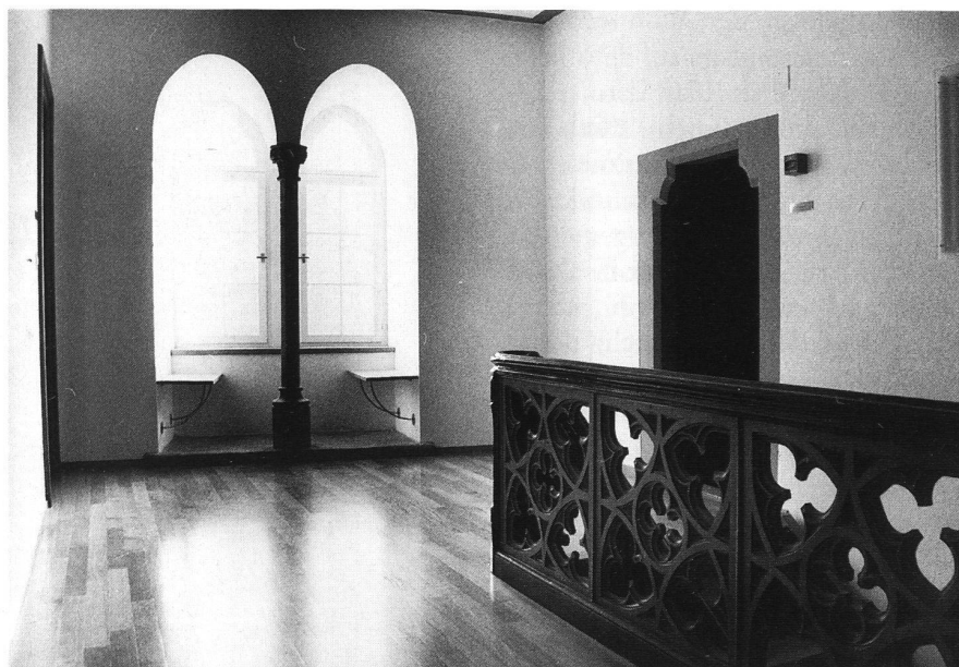
42: Treppenhause zwischen dem Palas D und dem Wohnturm A (rechts), mit Fenstersitznische, geschultertem Turmtür-Gewände und Masswerk-Treppenbrüstung in neugotischer Gestaltung von 1850.
