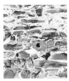
23: Wohnturm A von 1243, Südfassade im Bereiche des 2. und 3. Obergeschosses: romanisches Lochfensterchen mit eingekerbtem Zierkreis und gleich eine Steinlage höher Balkenstümpfe als Bugauflager zu einem überkragenden Obergaden.
