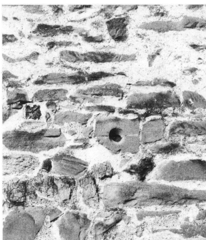
23: Wohnturm A von 1243, Südfassade im Bereiche des 2. und 3. Obergeschosses: romantisches Lochfensterchen mit eingekerbtem Zierkreis und gleich eine Steinlage höher Balkenstümpfe als Bugauflager zu einem überkragenden Obergaden.
