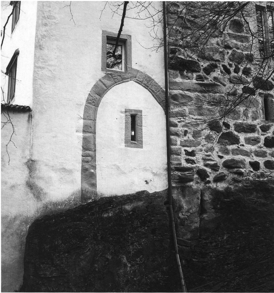
39: Mittelalterliches Tor und Westfassade des Wohnturmes A, beide über dem zum Halsgraben senkrecht abgeschroteten Felsrücken; rechts unterhalb des Tores Balkenaufleger zum einstigen Holzsteg (hinter der Dachwasserrinne).
