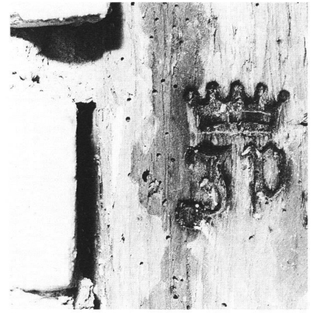
38: Palas D von 1451, 2. Obergeschoss: Brandstempel nicht gedauteter Herkunft auf einem Balken unbekannter Zeitstellung – das Zeichen eines Zimmermeisters?
