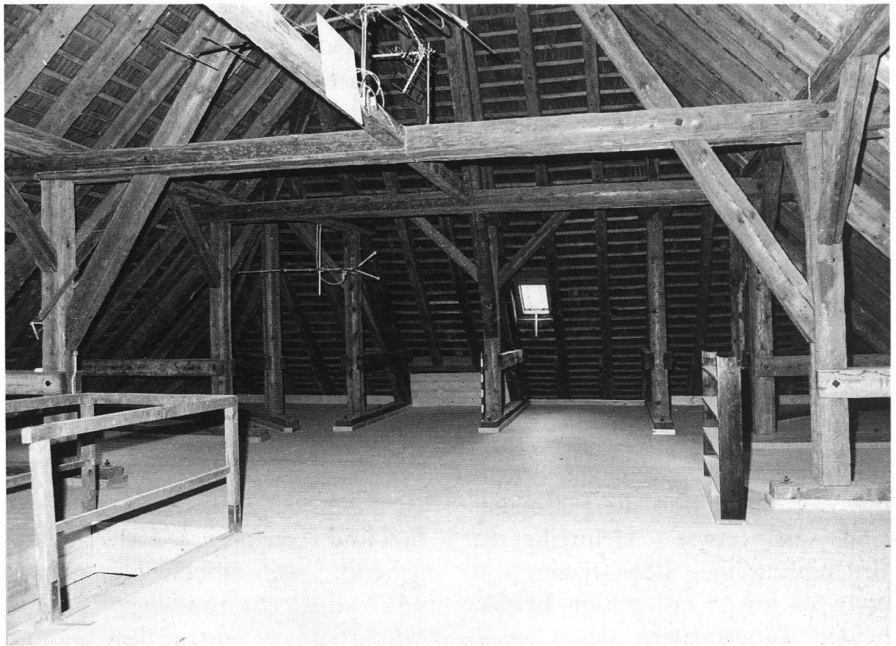
31: Osttrakt: Dachstuhl von 1885 in zeittypischem eisenschraubten Abbund.
