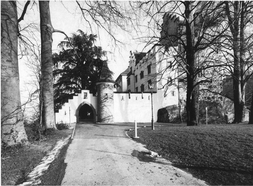
4: Westansicht mit alleearter Zufahrt, zinnenbekrönter Hofmauer mit Tor, Schalenturm und Schiesscharten von Pearsall um 1850, in der Achse von Zufahrt und Tor wächst im Schlosshof eine mächtige Zeder; rechts die mittelalterliche Burganlage auf dem zu drei Seiten zurechtgeschroteten Felsrücken.
