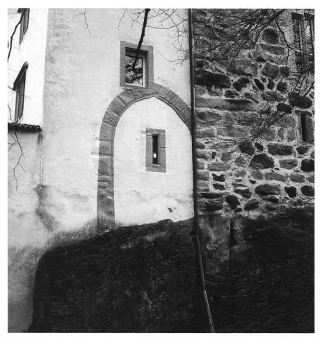
39: Mittelalterliches Tor und Westfassade des Wohnturmes A, beide über dem zum Halsgraben senkrecht abgeschroteten Felsrücken; rechts unterhalb des Tores Balkenauflager zum einstigen Holzsteg (hinter der Dachwasserrinne).
