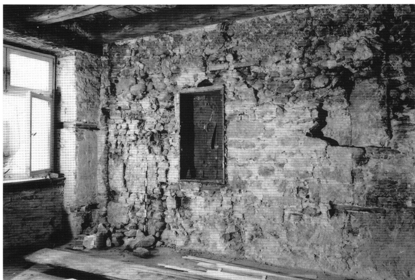
7: Ausschnitt der nordwestlichen Brandmauer, Teil an der Strasse. Spätmittelalterliches Mauerwerk mit abgearbeiteter Fensterleibung am rechten Bildrand.
