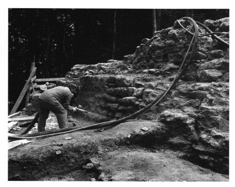
5: Der Ausschnitt Abbildung 10 während der Konservierung durch Kalkmörtelverfugung im Spritzverfahren.
