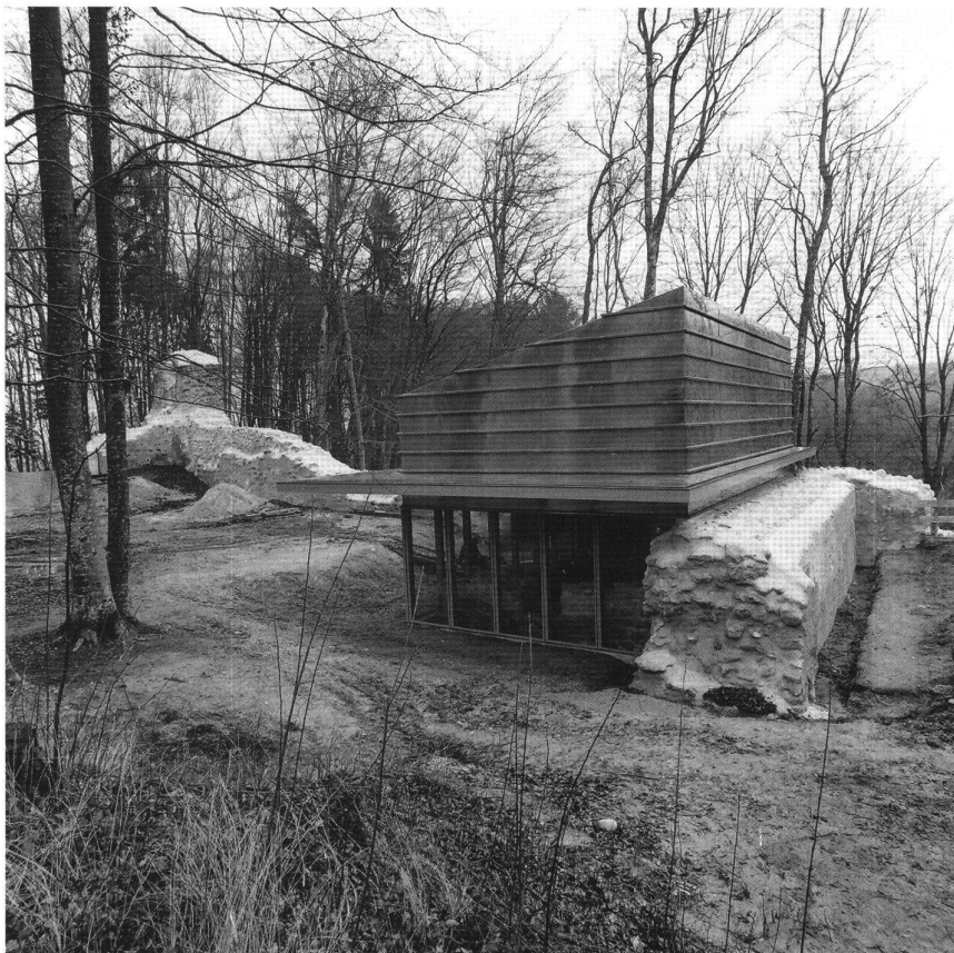
3: Der neue Schutzbau von Westen.
