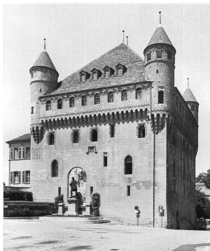
2: Château St-Maire. Construit entre 1397 et 1427 par l'évêque. Son couronnement en brique témoigne de l'intervention de maçons du nord de l'Italie au début du XV e siècle. – Zwischen 1397 und 1427 vom Bischof erbaut. Sein Maschikulkranz aus Backstein zeigt den Einfluss piemontesischer Baukunst seit dem Beginn des 15. Jhs.
