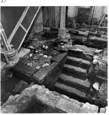
ge Mauerwerk ist 1,50 m stark, die Wasserseite besteht aus Hausteinen mit geflächten Spiegeln und quaderförmigen Bruchsteinen.
