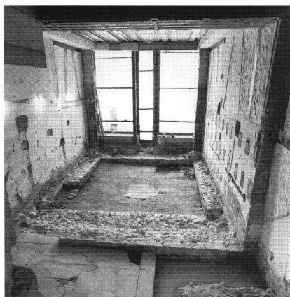
7: «Vorderer Schwert-Turm», Blick von Norden ins 6 m hohe Erdgeschoss des Turmes; der mächtige Mauersockel von 1,8 m Stärke wurde im 19. Jahrhundert aufgebrochen.
