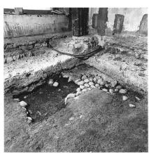
8: «Vorderer Schwert-Turm», das älteste gefasste Niveau im Erdgeschoss war ein Mörtelgussboden über einer Steinrollierung.
