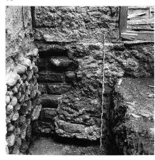
Das nahezu rechtwinklige Anstossen der ersten Uferverbauung an den «Schwertturm» berücksichtigte die Strömungskraft der Limmat zuwenig. Schon bald musste dieser Umstand mit einem strömungsmässig günstigeren Mauerwinkel korrigiert werden (Abb. 2/2). Dieser wurde nun exakt an die Südostecke des «Schwertturmes» angefügt und mit der bestehenden Ufermauer verbunden (Abb. 14). Das zweihäupti-
