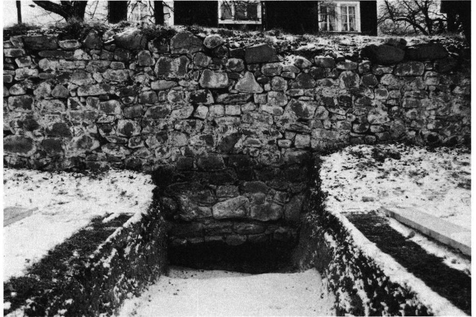
Schnitt B an die Gartenmauer. Die trocken aufgeschichtete Gartenmauer ist nur wenig in den Lehmuntergrund fundiert.
