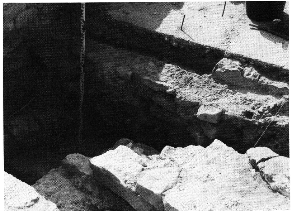
Südteil des Vorraumes. Im Vordergrund Fundamentrest der Bauperiode I. Darüber Fundament der Periode III, gegen die Aussenwand anlaufend.
