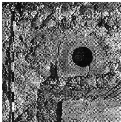
Abb. 5: Okulus aus der Kernbauzeit des «Roskopf»; möglicherweise lag er über einem zeitgleichen Türgericht, vgl. die Umzeichnung, Abb. 6.
