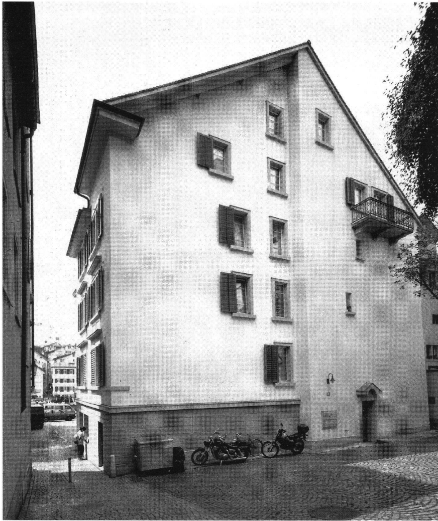
Abb. 15: Metzgergasse 3, «Tanzforst». Blick auf die heutige Ostfassade. Die ursprüngliche Fassade und spätere Brandmauer wurde durch die neuen Fensteröffnungen erneut zur Fassade.
