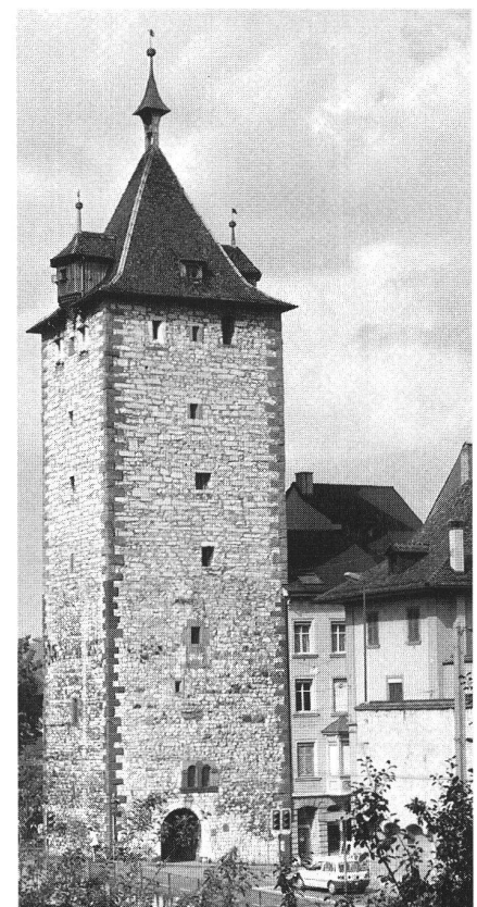
Abb. 2 Der Obertorturm, im späteren 12. Jahrhundert als Wohnturm erbaut; 1491 von der Stadt um die obere Hälfte aufgestockt. Rechts teilweise verdeckt von der jüngeren Stadtmauer das Oberhaus. Möglicherweise lag hier eine allfällige Stadtburg der Nellenburger beziehungsweise die 1098 erwähnte Burg des Vogtes.
