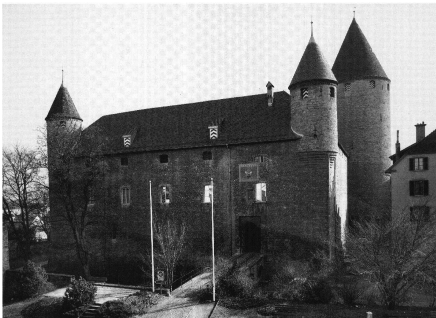
Schloss Bulle, Gesamtansicht. Rechts der mächtige Donjon aus dem frühen 13. Jahrhundert, links das Mauergeviert mit den Pfefferbüchsen (Kantonale Denkmalpflege Freiburg).
