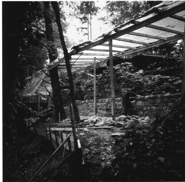
Abb. 11 Konservierungsarbeiten an der Mauer M 1.
