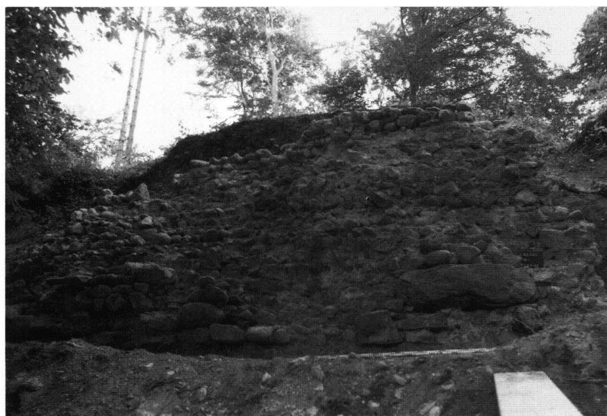
Abb. 8 Westlicher Teil der Mauer M 1. Im Fundamentbereich liegt ein grosser Findling; die Steine im Mauerkern sind sehr regelmässig.
