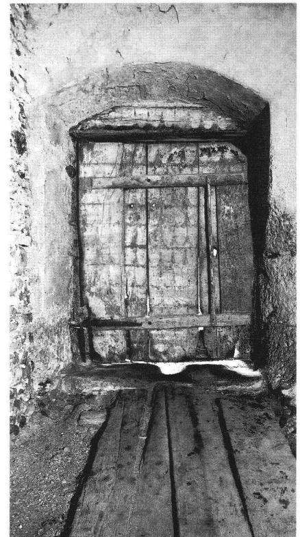
Palas von 1318. Unterer Saal: Portal in der Südwand mit originalem Türblatt. Es dreht sich oben noch mit einem herausgeschnitzten Drehzapfen im Drehloch des Sturzbalkens. Über Sturz und Türblatt zieht der Fehbesatz.
