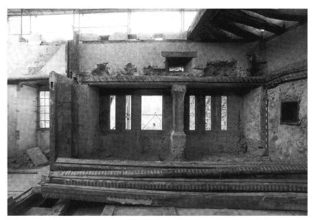
Palas von 1318. Truchsessenstube. Südwand mit Fensterscharten. Links Reste der Bohlenständerwand, die diesen Raum vom oberen Saal im Osten abtrennte. Über dem Sturz der Fensternische: Südwand des ehemaligen Blindbodens zwischen der Bohlen-Balken-Decke und der tragenden Balkenlage. Von dieser ist rechts oben noch der westliche Balkenfächer sichtbar, der den Palas-Obergaden im Westen trug. Links davon sind noch die Negative der beim Umbau von 1991 entfernten Balken zu erkennen.
