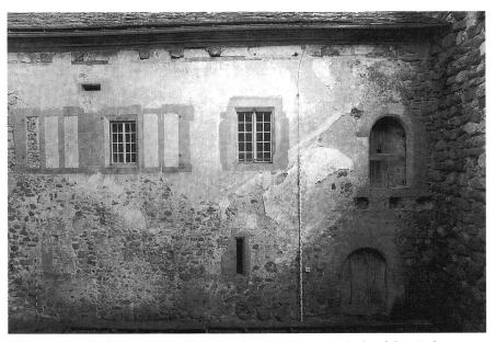
Palas von 1318. Südfassade mit dem Erdgeschoss-Portal in den unteren Saal und dem Hocheingang in den oberen Saal. Im Westen die vermauerten Scharten der Wohnstube.
