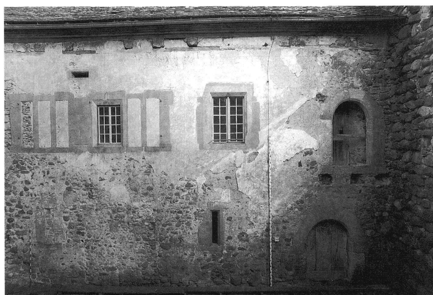
Palas von 1318. Südfassade mit dem Erdgeschoss-Portal in den unteren Saal und dem Hocheingang in den oberen Saal. Im Westen die vermauerten Scharten der Wohnstube.
