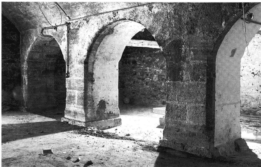
Keller von 1329. Zweischiffiger Raum mit mittlerer Arkadenwand, darüber zwei Längstonnen.
