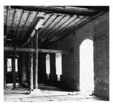
Palas von 1318. Unterer Saal mit den grossen Fenstern nach Norden und Westen. Die Deckenbalkenlage und Bretterdiele mit den gefasten Fugenleisten stammen aus der Bauzeit. Aufnahme nach Nordwest.
