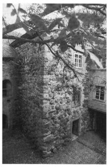
Turm von 1186. Aufnahme 1989 nach Nordost. Der Turm ist in megalithischer Mauertechnik mit Findlingen gefügt, die weitgehend unbearbeitet sind und nur einen Kantenschlag aufweisen. Diese Bauform ist nicht speziell kyburgisch, sondern zwischen Bodensee und der mittleren Aaregegend überall anzutreffen, wo entsprechende Steine vorkommen.
