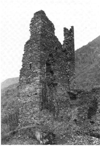
Norantola, Hauptturm mit Hocheingang.
