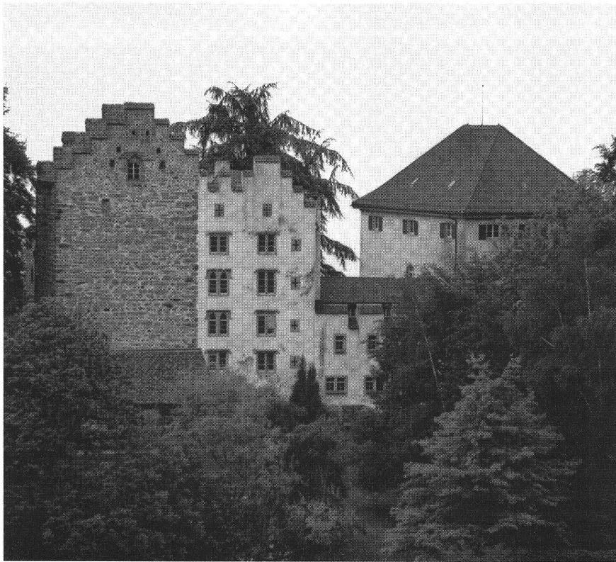
Wartensee. Stark veränderte Burganlage mit hochmittelalterlichem Westturm mit Staffelgiebel und Wohnbauten aus dem 18. und 19. Jahrhundert.
