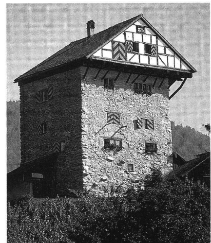
Neu-Altstätten. Wohnturm mit vorkragendem Fachwerkoberbau.
