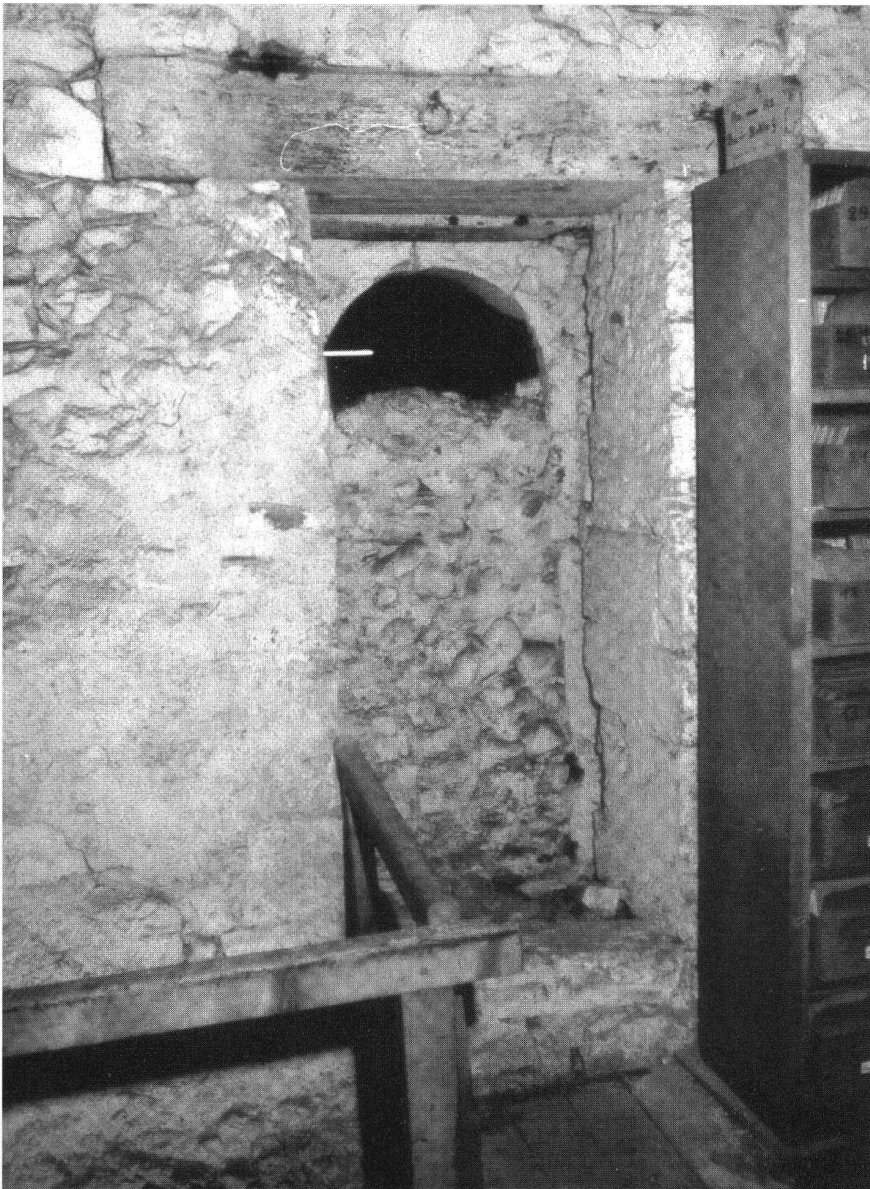
Kleine Rundbogenpforte zum Treppenhaus, Blick von SO. Westwand des Steinhauses von 1140. Salzstrasse 18.
