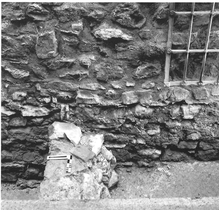
Innenseite der Turmmauer M 1d und Aufsicht der Mauer M 2. Der Mörtel der Mauer M 1d ist bis UK Gitter original. Der darüber sichtbare, glattgestrichene Fugenmörtel wurde bei der letzten Konservierung aufgetragen. (Aufnahme Ph. Saurbeck)
