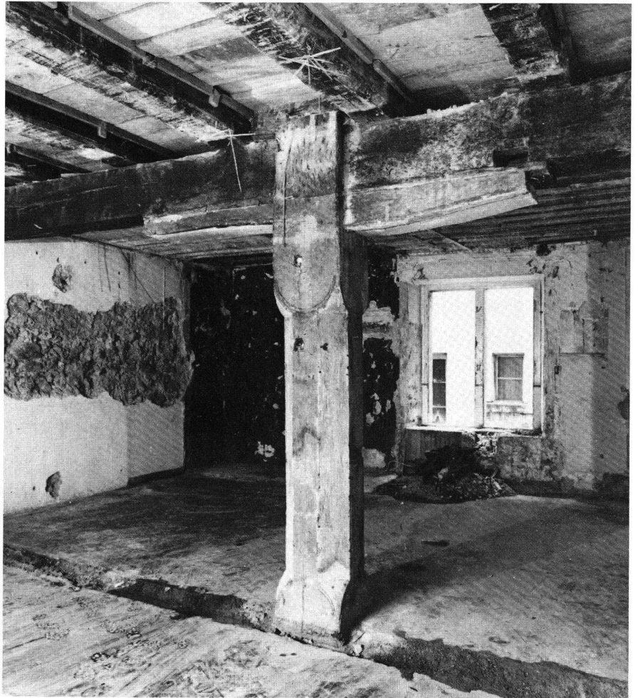
9 Widdergasse 6. Die Stützkonstruktion mit Stud, Sattelholz und Unterzug gehört in die Zeit um 1300.
