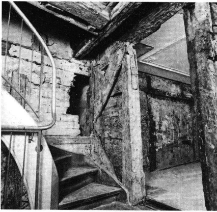
7 Augustinergasse 34, «Turteltäubli». Hinter Bauteilen des 19. und 20. Jahrhunderts hat sich hier die Ständerkonstruktion mit Bohlenwänden aus dem 15./16. Jahrhundert erhalten. Die durchbrochene «Brandmauer» gibt hier bereits den Blick frei ins Nachbarhaus.
