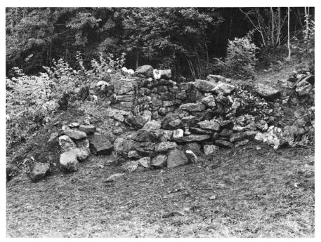
Abb. 5: Kalkofen Isenthal UR. Ansicht des Ofens von Westen. Der Ofen ist zur besseren Isolation in den Abbang hineingebaut.
