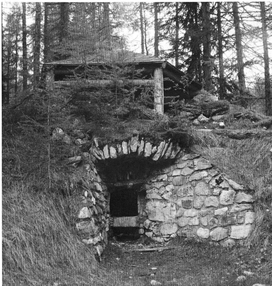
Abb. 2: Kalkofen von Fuldera GR. Dieser Kalkofen war noch bis um 1930 in Betrieb und kann heute als konservierte Ruine besichtigt werden. Unten die Feuer- und Schüröffnung (Schnauze), oben das Schutzdach über dem Ofen.
