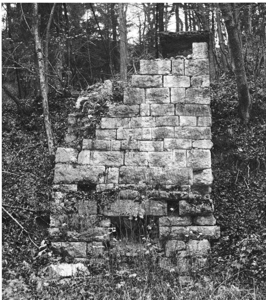
Abb. 3: Schachtkalkofen von Rickenbach SO. Der Ofenmantel besteht aus sorgfältig gefügten Kalksteinquadern; das Ofeninnere ist mit Schamottsteinen ausgefüllt.
