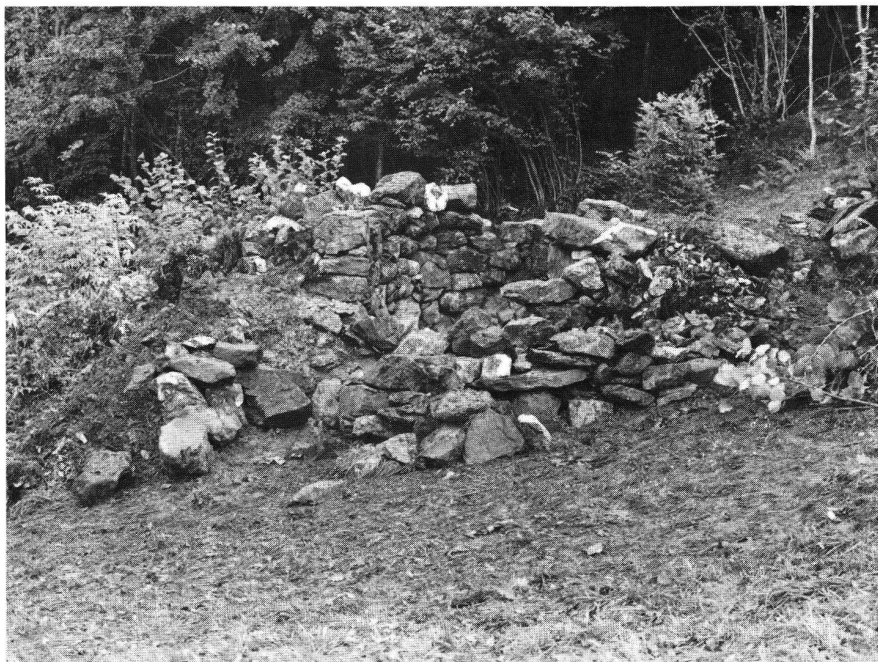
Abb. 5: Kalkofen Isenthal UR. Ansicht des Ofens von Westen. Der Ofen ist zur besseren Isolation in den Abhang hineingebaut.
