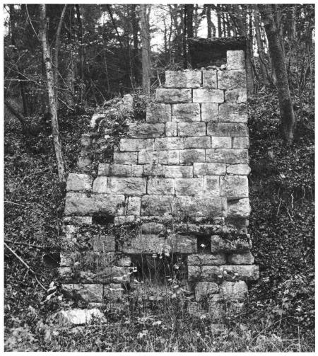
Abb. 3: Schachtkalkofen von Rickenbach SO. Der Ofenmantel besteht aus sorgfältig gefügten Kalksteinquadern; das Ofeninnere ist mit Schamottsteinen ausgefüttert.
