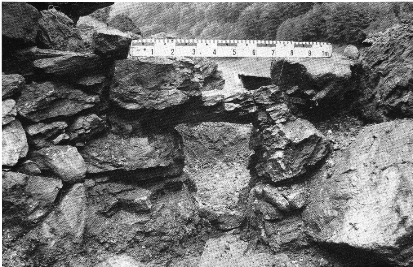
Abb. 6: Kalkofen Isenthal UR. Schmale Schür- und Feueröffnung (Schnauze).
