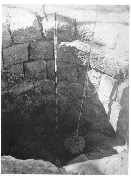
Aushubarbeiten am Sodbrunnen 1945. Der Schacht ist etwa 2 Meter tief von Schutt befreit. An den Quadern der zweitobersten Lage meint man noch die originalen Steinbearbeitungsspuren zu erkennen. Foto: Otto Sigrist, Horw.
