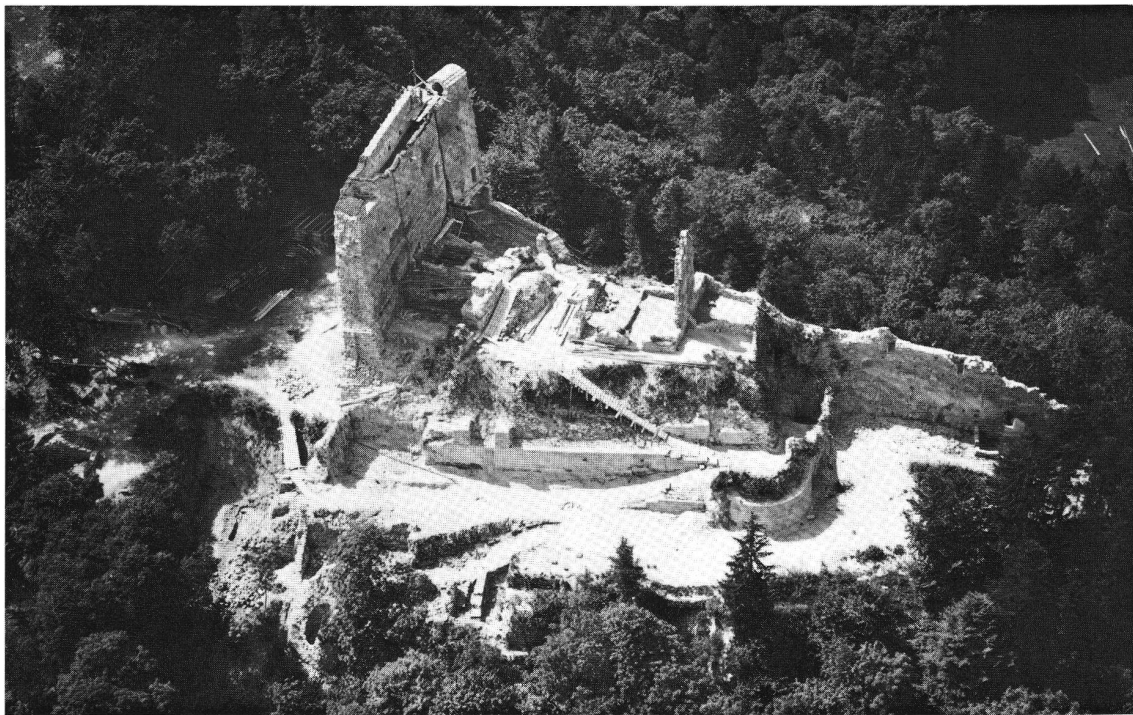
Farnsburg BL, Luftaufnahme während den Restaurierungsarbeiten um 1931.
