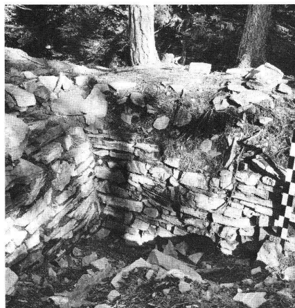
Ober-Ruchenberg bei Trimmis (GR). Von Schatzgräbern freigelegter Mauerwinkel, trocken geschichtet, im bergseitigen Vorburgareal. Mauerkante mit deutlichen Auflösungserscheinungen.
