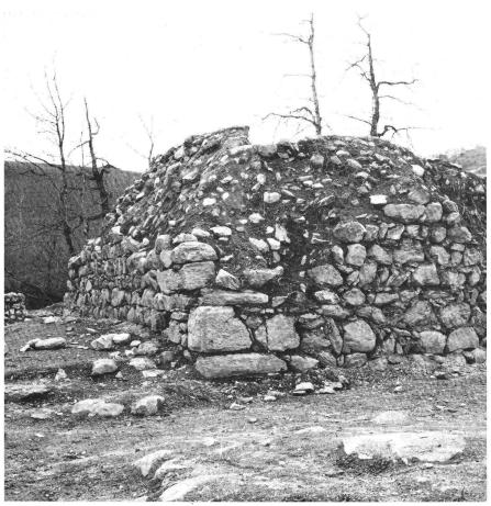
Burgstelle Grünfels bei Waltensburg (GR). Reste des Hauptturms unmittelbar nach der Freilegung. Das unkonservierte, sich selbst und der Vegetation überlassene Mauerwerk befindet sich nunmehr seit Jahren in Auflösung. Begonnen hatte die Tragödie seinerzeit mit unqualifizierten Freilegungsarbeiten durch eine Jugendgruppe unter der Leitung eines Pfarrers (!).
