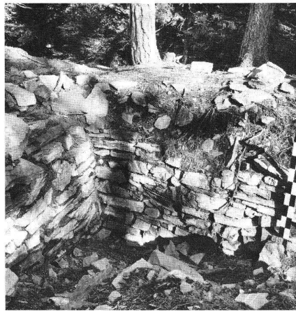
Ober-Ruchenberg bei Trimis (GR). Von Schatzgräbern freigelegter Mauerwinkel, trocken geschichtet, im bergseitigen Vorburgareal. Mauerkannte mit deutlichen Auflösungserscheinungen.
