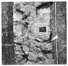
Abb.8 Ältere Stadtmauer. Der Pfeil markiert die Baunaht zwischen dem aus Sandstein gemauerten Teil (unten) und dem aus Bollensteinen gefügten Abschnitt (oben) (Photo F. Mächler).
