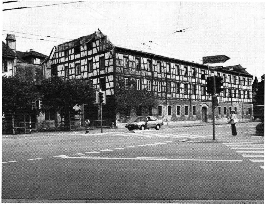
Abb. 3 Der Riegelbau der Alten Kaserne von Südwesten. Links des Gebäudes die Stadtmauer (Photo C. Renold).
