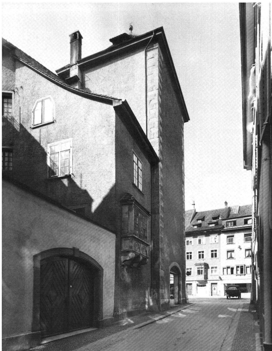
Schaffhausen. Mittelalterlicher Wohnturm.
