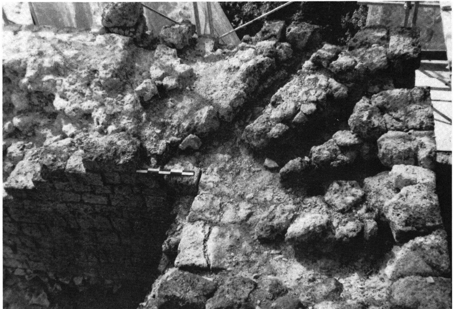
Photo 12 Tour de Milandre, sommet dégagé et nettoyé. Système de chenaux de poutres saillantes en encorbellement sur les murs. Cette installation a seulement été trouvée sur le côté vallée.
