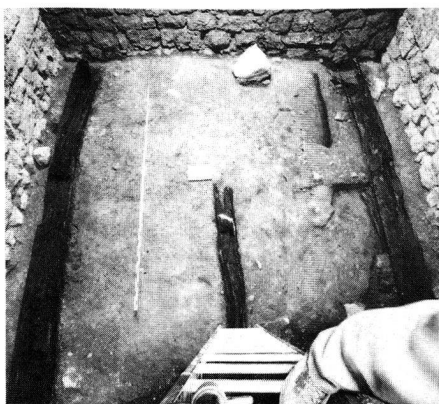
Der heutige Schlossturm entstand im frühen 13. Jh., indem man seinen hölzernen Vorgänger zunächst stehen liess und mit einem Mauermantel umschloss. Unser Bild zeigt die erhaltenen Eichenschwellen. Ihre dendrochronologische Bestimmung lässt die Bauzeit des Holzturms um 1180 ansetzen.
