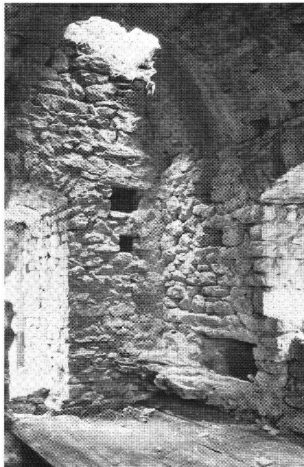
San Vittore GR. Torre Pala, 5. Geschoss. Oben der jetzige Durchstieg zur Plattform (Zisterne), unten der Schüttstein
