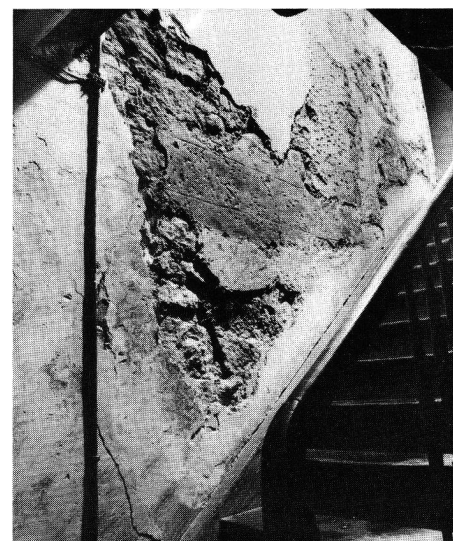
Abb. 22: Die höfliseitige Schauffassade des «Kleinen Regenbogens» wurde mit horizontalen Fugenstrichen dem stattlicheren Nachbarburturm «angepasst».
