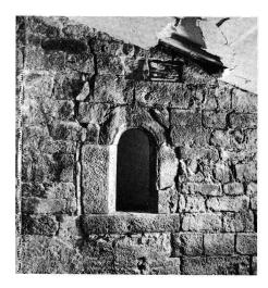
Abb. 15: Romanisches Fenster im 2. Obergeschoss der «Glentnerturm»-Westfassade. Sorgfältig gefügtes Hausteinmauerwerk umschliesst die feingearbeiteten Gewändesteine.
