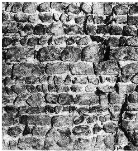
Abb. 16: Innenansicht der «Glentnerturm»-Westfassade im 2. Obergeschoss. Lagenhaft gemauerte Mauerschale aus Bollen- und Lesesteinen.
