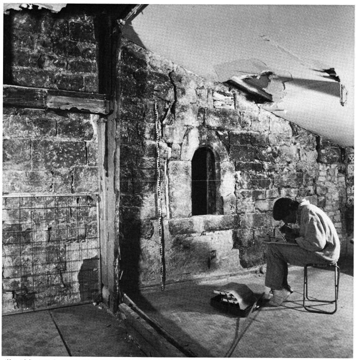
Abb. 5: Blick vom Dachgeschoss des limmatseitigen Anbaus an die «freigelegte» Schaufassade des «Glentnerturmes». Sorgfältig gefügtes Hausteinmauerwerk umschliesst das romanische Rundbogenfenster.
