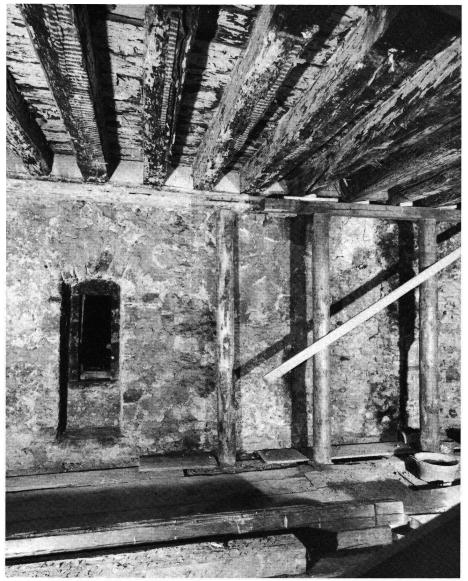
Abb.21: «Glentnerturm», Innenansicht an das Fenster im 3. Obergeschoss der Ostfassade. Unregelmässig dicht sind die mittelalterlichen Geschossbalken direkt ins Mauerwerk verlegt.
