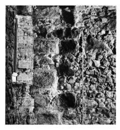
Abb. 17: Südostecke des «Glentnerturmes» mit Bossenquadern und lagenhaftem Mauergefüge aus Bollen- und Lesesteinen.
