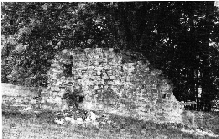
Ringmauer, NW-Partie. Inneres Mauerhaupt mit Gerüstbebellöchern.
