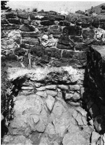
Schnitt S1, Blick gegen N. Inneres Haupt der Ringmauer. Der Massstab steht auf modernem Zementfuss. Darunter originales Mauerwerk. Obere Mauerteile rekonstruiert.
