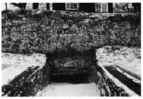
Schnitt B an die Gartenmauer. Die trocken aufgeschichtete Gartenmauer ist nur wenig in den Lehmuntergrund fundiert.
