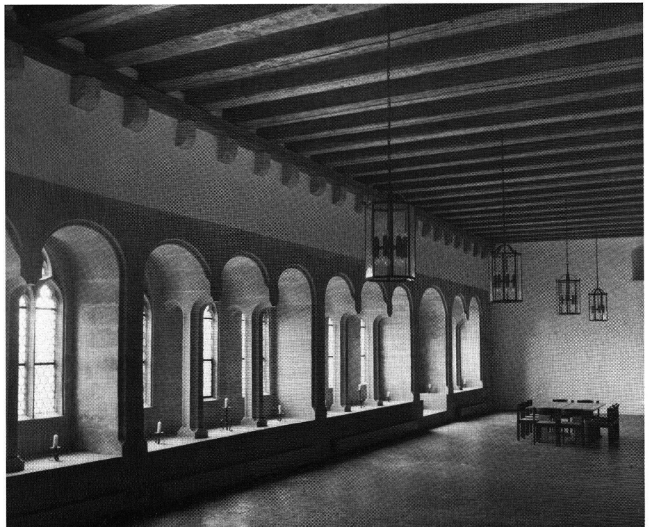
Ritterhaus, Blick in den unteren Saal nach erfolgter Rekonstruktion des gotischen Fensterbandes.
