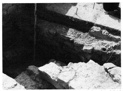
Südteil des Vorraumes. Im Vordergrund Fundamentrest der Bauperiode I. Darüber Fundament der Periode III, gegen die Aussenwand anlaufend.
