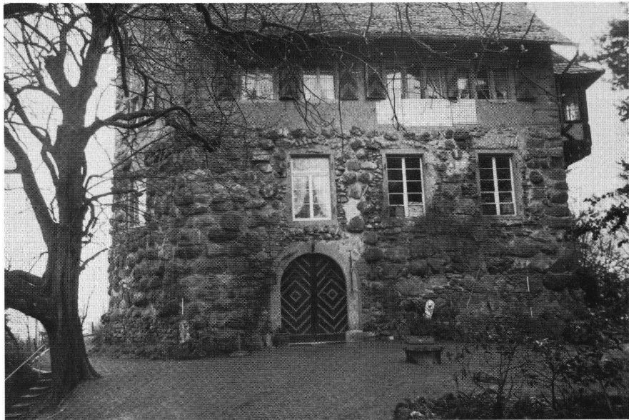
Wellenberg TG, südliche Schildmauer/ Fassade.
