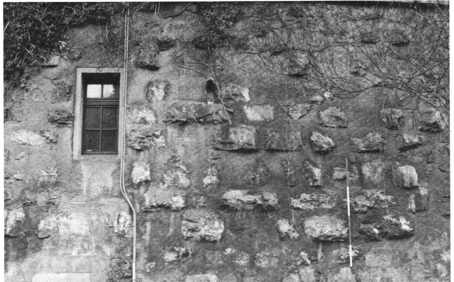
Schloss Zwingen, Teil der Palas-Nordmauer im westlichen Bereich.
