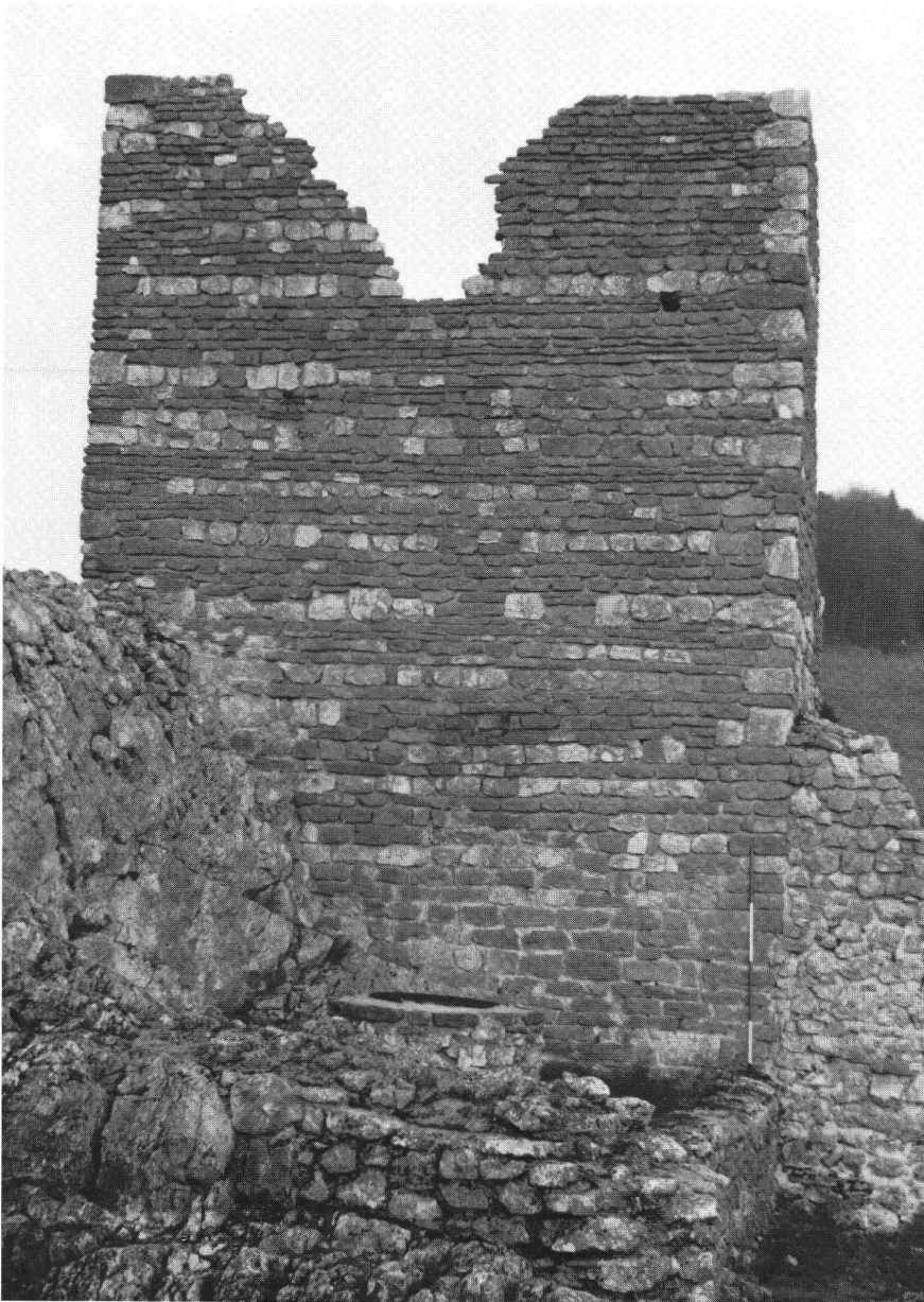
Alt-Bechburg SO, Westfassade des Turmes in der östlichen Burg.
