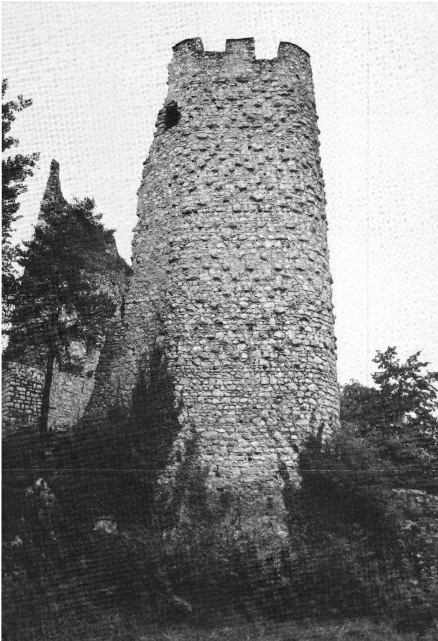
Pfeffingen BL, Westfassade des Wohnturms.
