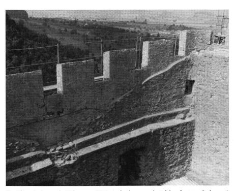
Neu-Thierstein, Inneres des Wohnturmes. W-Mauer des obersten, nachträglich aufgesetzten Geschosses mit rekonstruiertem Zinnenkranz und V-förmigem Mauerabsatz für die doppelte, nach innen geneigte Dachschräge. Zustand 1984.
