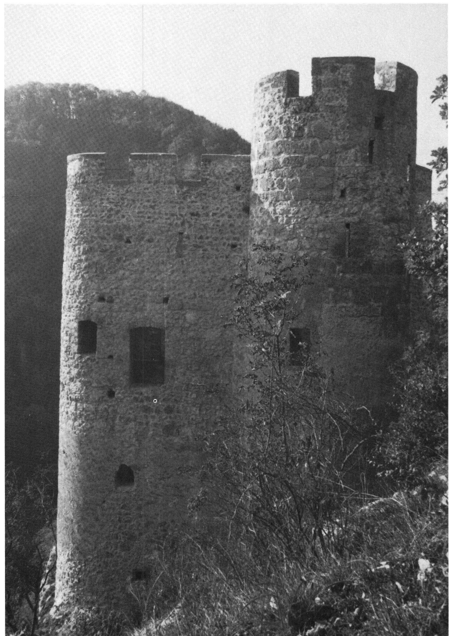
Neu-Thierstein, Ansicht des Wohnturmes von E. Zustand von 1985 nach der Restaurierung.
